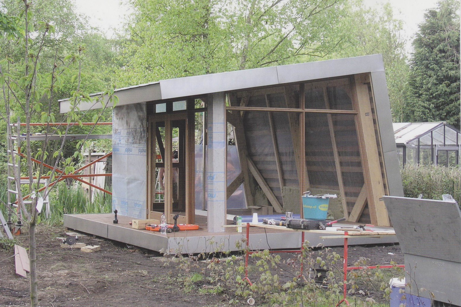
Firma Hamer & Hark bouwt nieuw huisje op complex mei 2009
